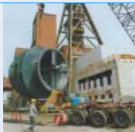
Mine ventilation fan
